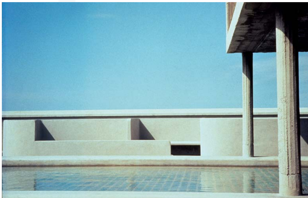
Toit-terrasse de l'Unité d'habitation, Marseille
