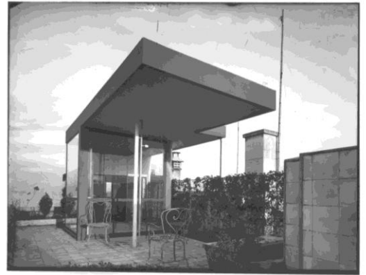
Le kiosque du toit-terrasse
