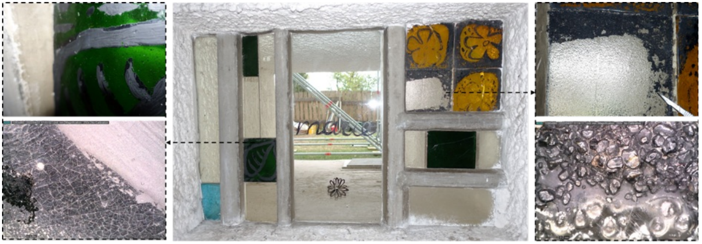
Au centre : vitrages de la façade sud avec peintures à froid en face intérieure. À gauche en haut : détail de la peinture à froid originale recouverte d'un repeint ultérieur. À gauche en bas : détail dans la même zone au microscope de terrain Dinolite (x50). À droite en haut : détail de la peinture à froid originale avec charge granuleuse grossière. À droite en bas : détail dans la même zone au microscope de terrain Dinolite (x50). Photos : CICRP - N. Bouillon / © AONDH / © FLC / ADAGP.
